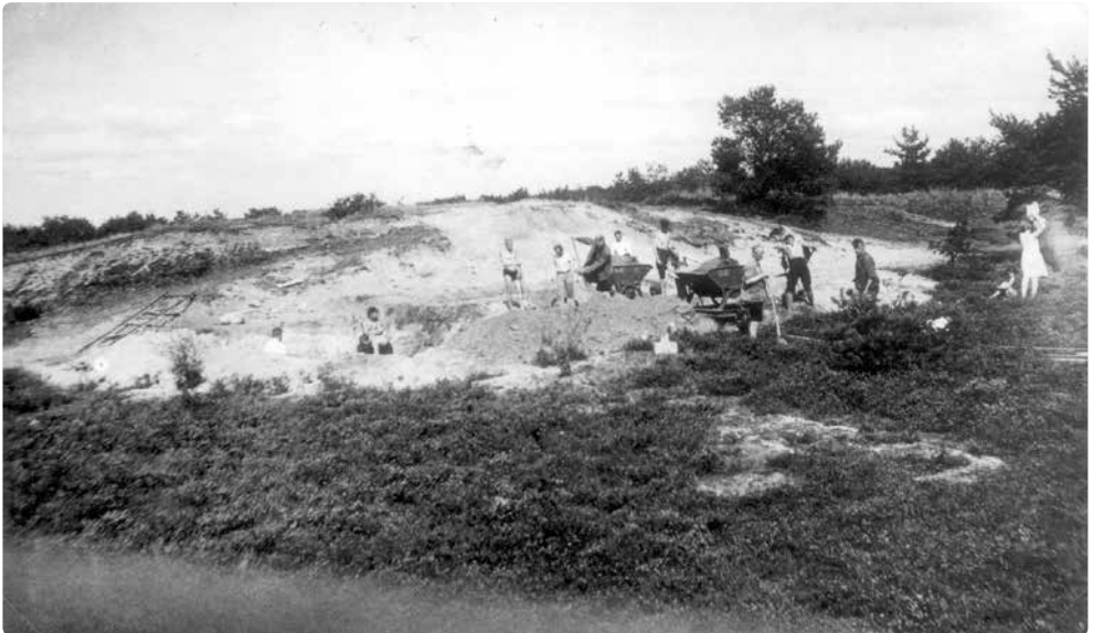
Bau eines Schwimmbeckens (1931)
